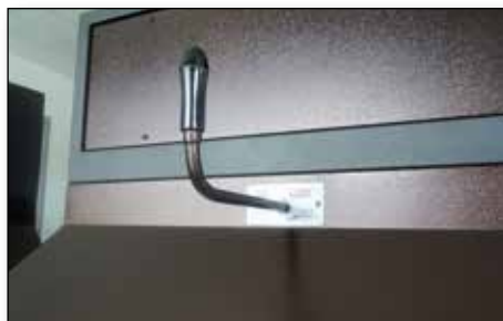
plénum et levier pour régler la valve d'aération
